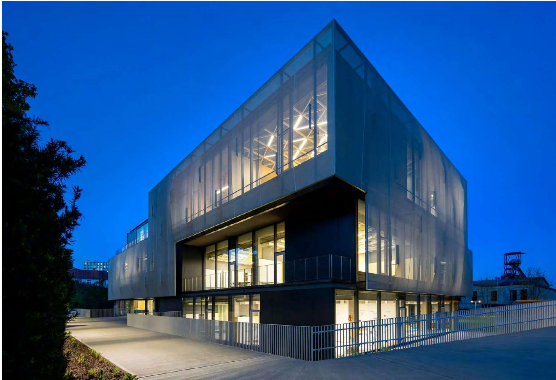
La membrane Serge Ferrari 381 FrontSide View utilisée sur cet ouvrage retient à 72 % la pénétration solaire dans l'espace tout en offrant un ressenti de 100 % de transmission visuelle sur l'extérieur.
